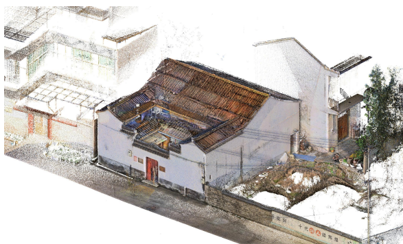
图 1 数字化固定式三维激光扫描点云图
